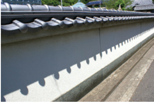
しっくい風の外観意匠（吹付塗装）の築地塀の例
