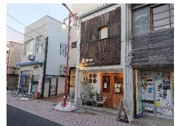
空き店舗のリノベーション
