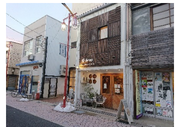
空き店舗のリノベーション
