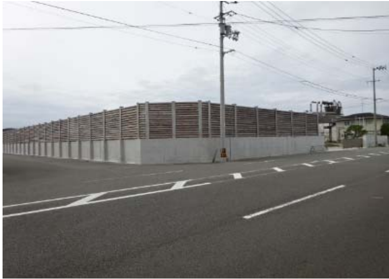
①敷地全景写真（東・南面）
