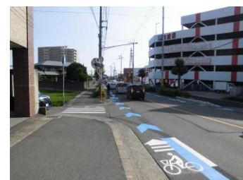
自転車走行空間整備
