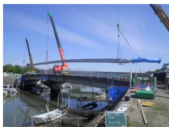
橋りょう添架管架替工事
