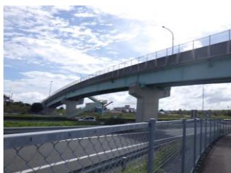
橋りょうの耐震補強
