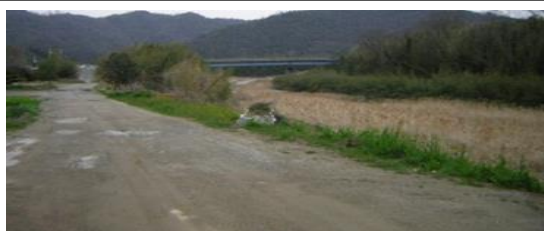
【園瀬川】川西地区・明善地区の堤防整備及び上中筋地区の漏水対策の促進
