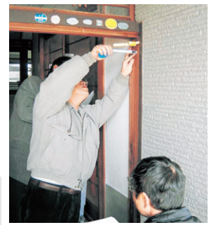
▲耐震診断の様子
