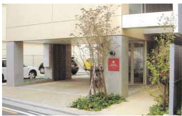
▲前方の道路と後方の川をつなぐ風の道をつけた共同住宅=第10回「風の空間賞」受賞
