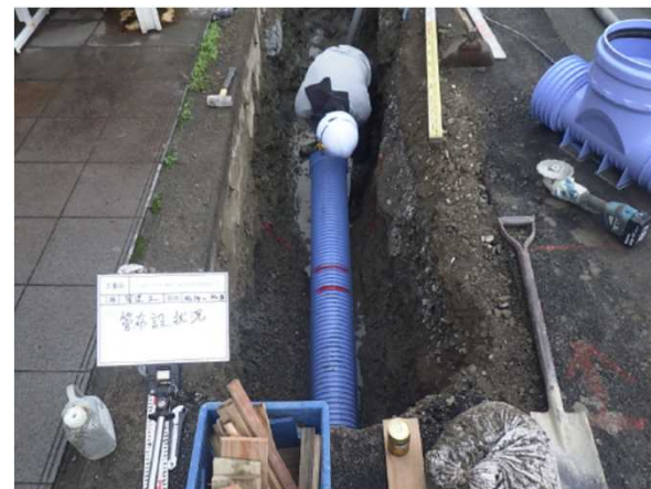
下水道管設置状況
