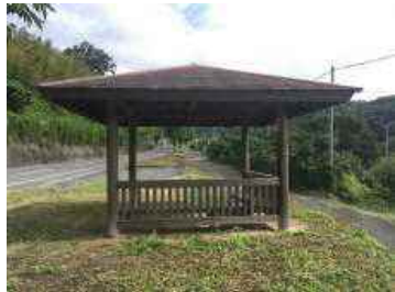
遍路小屋 (板野郡板野町)
