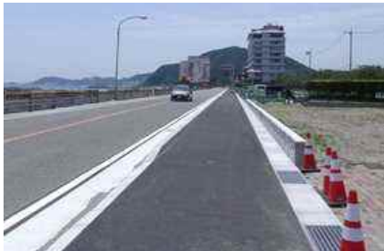
自転車歩行者道の整備 （県道 鳴門公園線 鳴門市鳴門町土佐泊浦）
