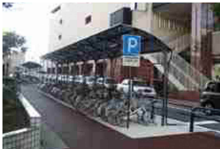
パーキングメーターの転用による駐輪場整備 (新潟市)
