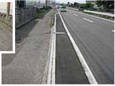
路側の改善（側溝の改修） （出典：愛媛県）
