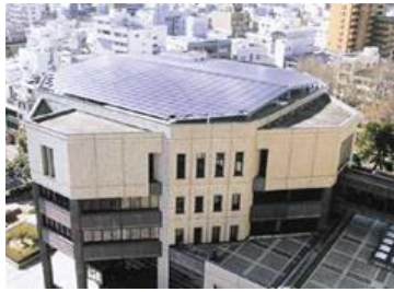
徳島市庁舎太陽光発電システム
