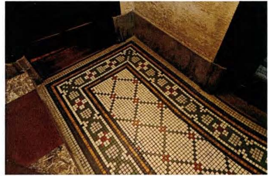
009 1階廣間階段室 床面
