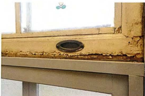
233 3階小供室（北）上下窓金具
