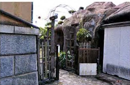
6. 裏庭門 主屋と岩屋の間に設置された、鉄筋コンクリートの擬木を用いた裏庭門
