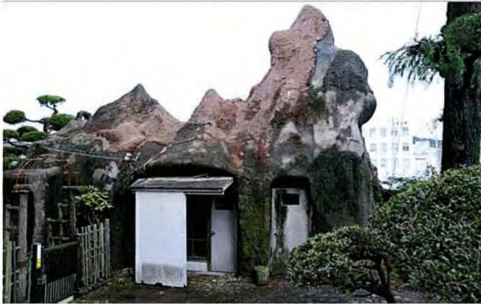
2. 岩屋（倉庫） 鉄筋コンクリートで造られた岩状の構造物。もとは中はがらんどうで、薪などの資材を保管していた。
