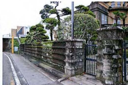
4. 門及び塀（左袖塀） 前面道路の拡幅に合わせて、門及び塀は一度移設されている。
