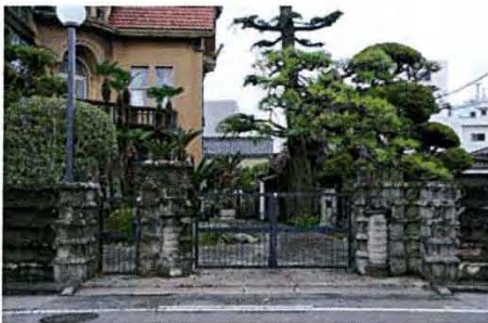
4. 門及び塀（門） 門の一部は石造、塀は鉄筋コンクリート造である。意匠を揃えた設計がなされている。
