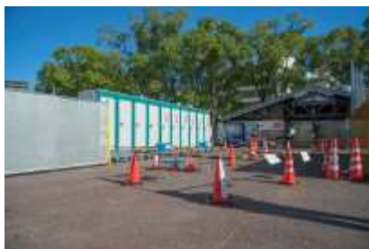
密集回避のため仮設トイレを設置
