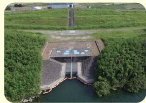
第6水源取水口
