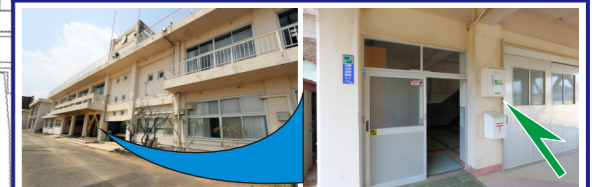
富田中学校 (東校舎(ピロティ内)南入口)
